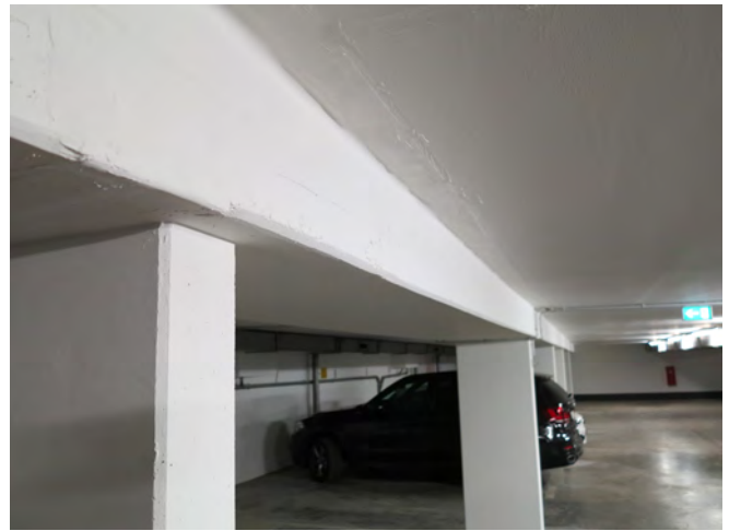
Bild 10 fertig sanierter Unterzug
