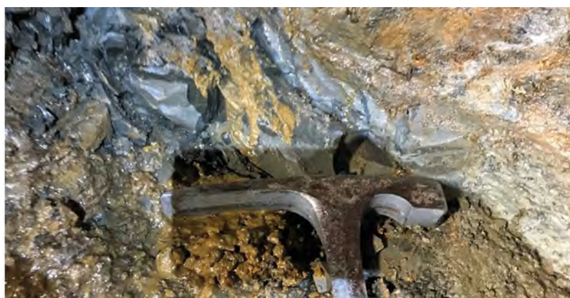
Bild 11 Verpresste Klüfte an der Ortsbrust
