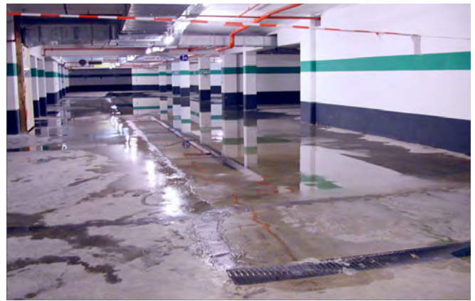
Bild 2 Undichte Risse in der Bodenplatte eines Parkdecks (Quelle: Bodo Appel, WEBAC)
