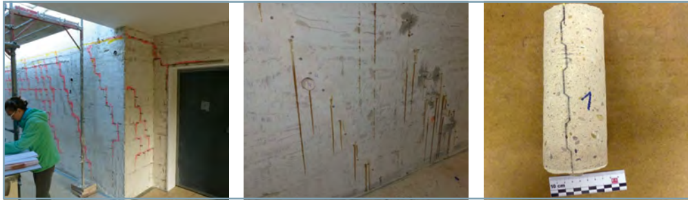
Bild 7 Injektionsmaßnahmen zum kraftschlüssigen Wiederherstellen des Mauerwerksgefüges
