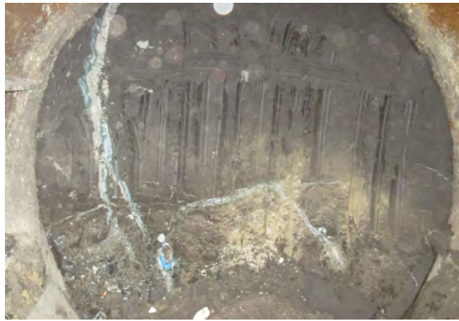
Bild 8 und 9 Ortsbrust Rohrvortrieb/Injektionsrohre und Verfestigungen
