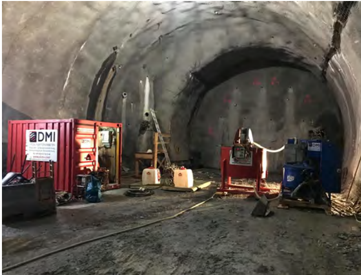
Österreich, Brennerbasistunnel HS2 Hochstegen Gebirgsinjektionen
