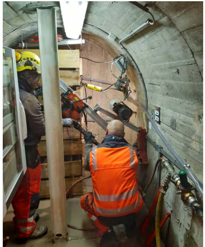
Bild 6 Bohrarbeiten in der Lotkammer
