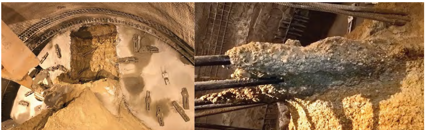
Bild 6 Gewölbesicherung mittels eines Spießschirms mit Acrylatgel verpresst (links); Detail der Spieße (rechts)
