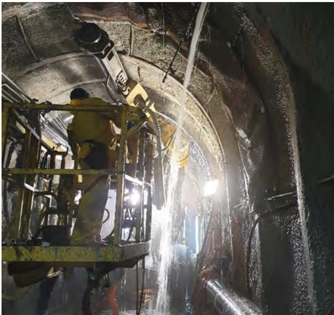
Bild 9 Wassereintritt beim Vortrieb des Druckstollens
