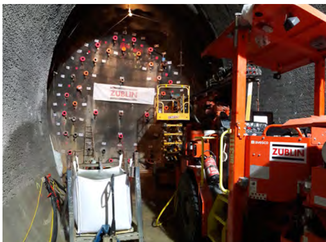
Bild 1 Tunnelvortrieb mit vorausseilenden Injektionen, Quelle: Züblin Spezialtiefbau
