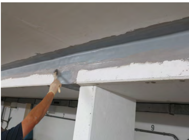
Bild 6 Dichtklebung der Fugen am Unterzug
