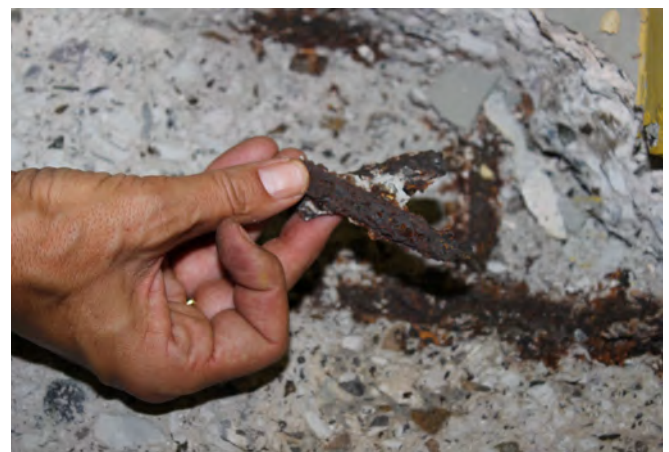
Bild 5 Bewehrungskorrosion von wasserführenden nicht selbstheilenden Trennrissen
