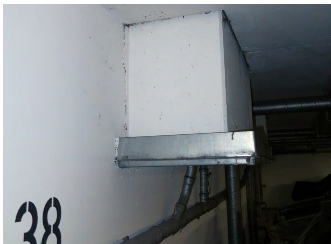
Bild 3 Lichtschacht mit Wasserauffangblech
