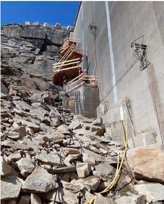
Bild 5 Konsolengerüste und Schutt auf orografisch linker Flanke
