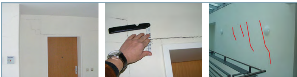
Bild 3 Rissbildung im 2. Obergeschoss; links: Türnische; Mitte: Türsturz; rechts: Wandfläche
