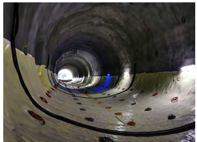
Bild 1 Prüf- und Injektionssystem einer KDB-Abdichtung in der Sohle im Bauzustand
