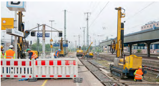
Bild 4 Herstellung der Bohrungen im Gleisbereich bzw. Bahnsteig
