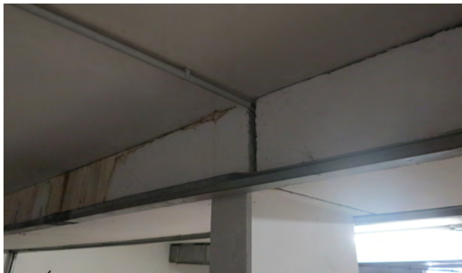
Bild 4 Unterzug mit Wasserlaufspuren und Auffangrinne
