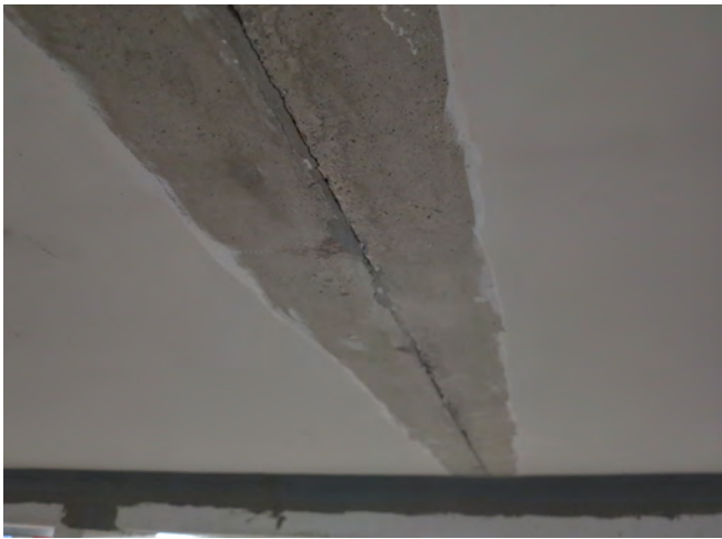
Bild 8 Stoßfuge zwischen Deckenfeldern (in Bearbeitung)
