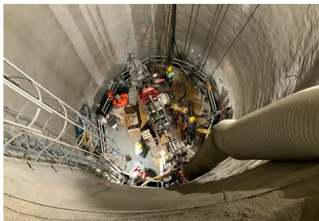
Bild 2 Herstellung der Bohrungen und Einbau der Manschettenrohre
